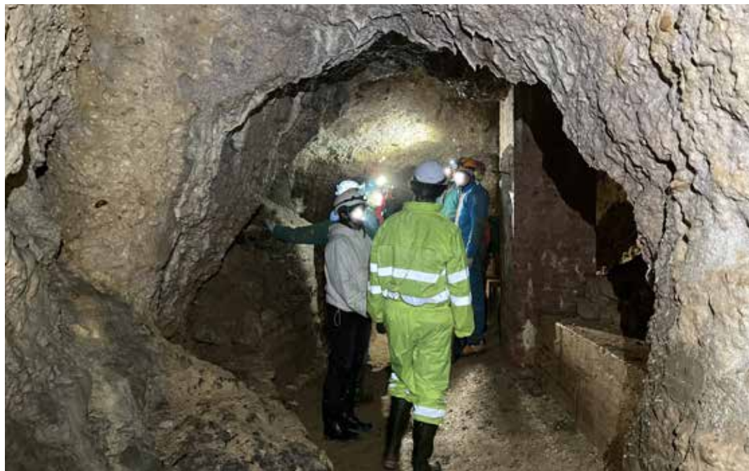
Asolo (TV), Acquedotto La Bot, visita all'interno della galleria di servizio
