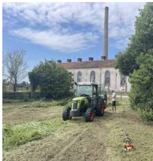
Sede, lavori di manutenzione giardino, foto M. Pellegrini
