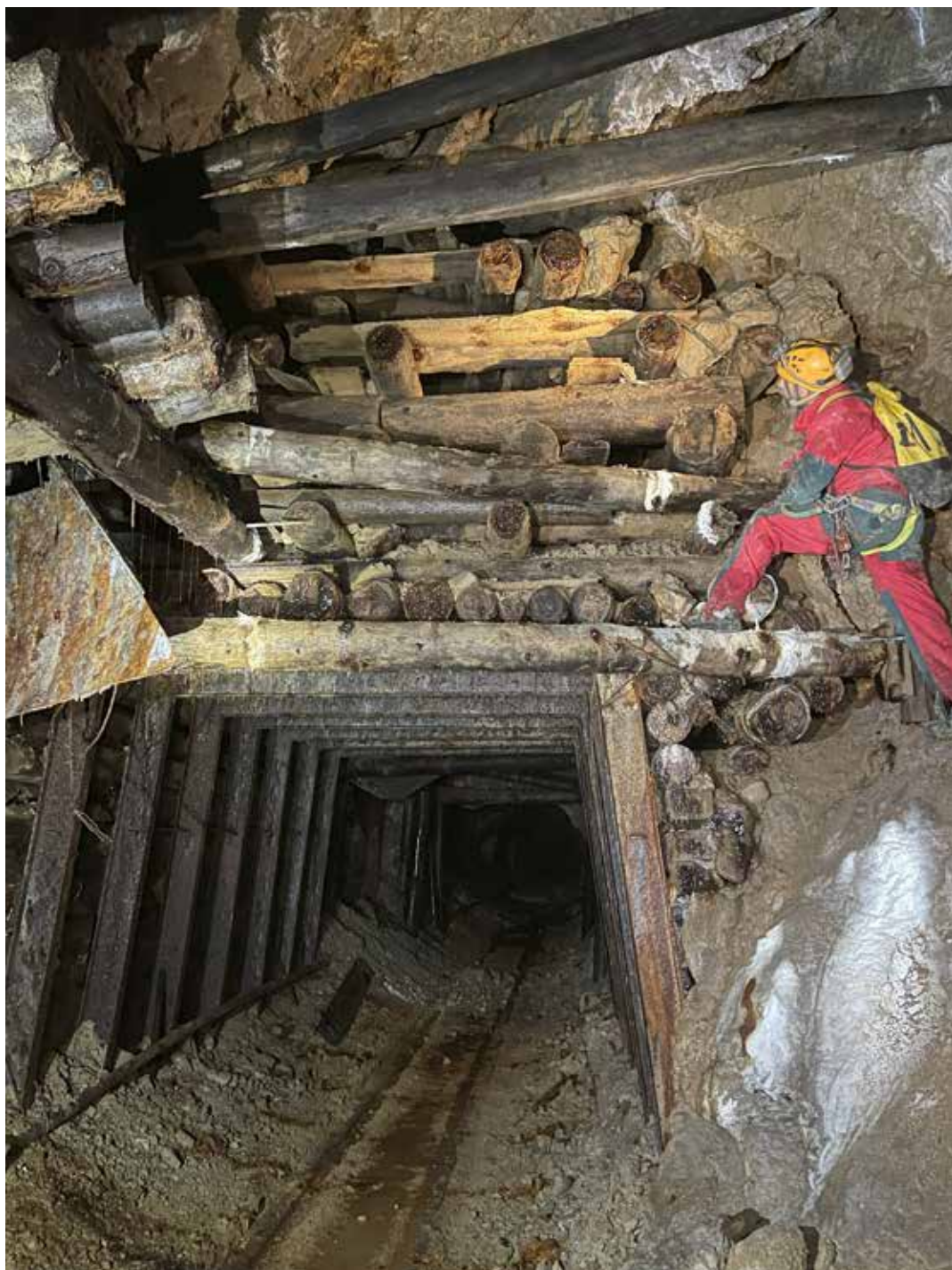
Miniera Salafossa, imponente impalcatura di sostegno di uno dei rami
