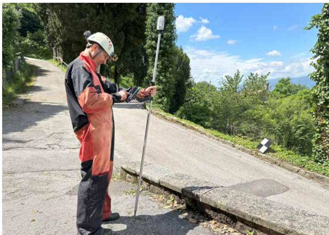
Asolo, Acquedotto La Bot, Georeferenziazione caposaldo per inizio scansione, foto Massimiliano Zago
