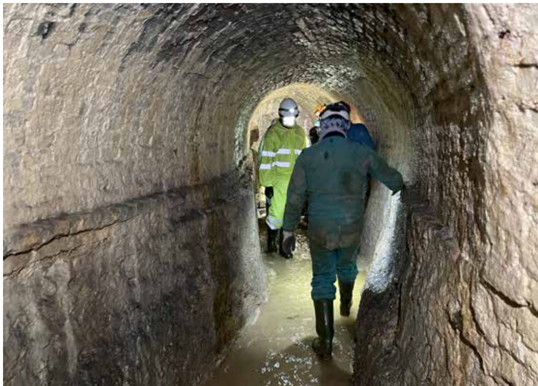
Asolo (TV), Acquedotto La Bot, visita all'interno della galleria di servizio, parte terminale
