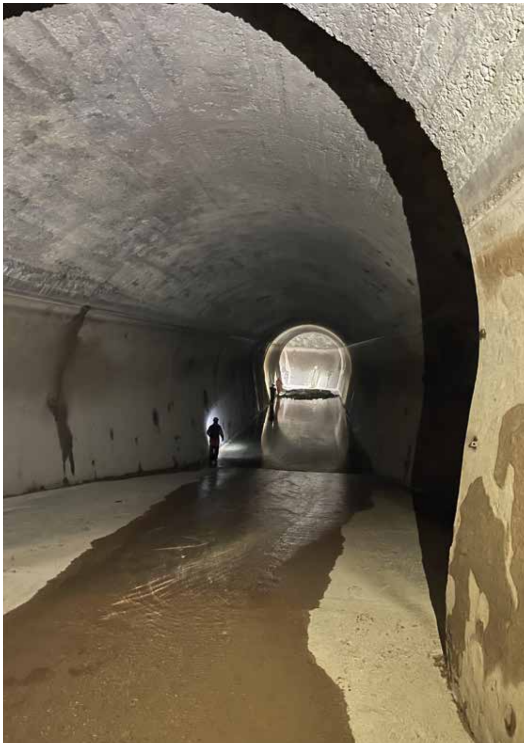
Canale di Castelviero, verso l'uscita in prossimità della centrale, foto Marcello Pellegrini
