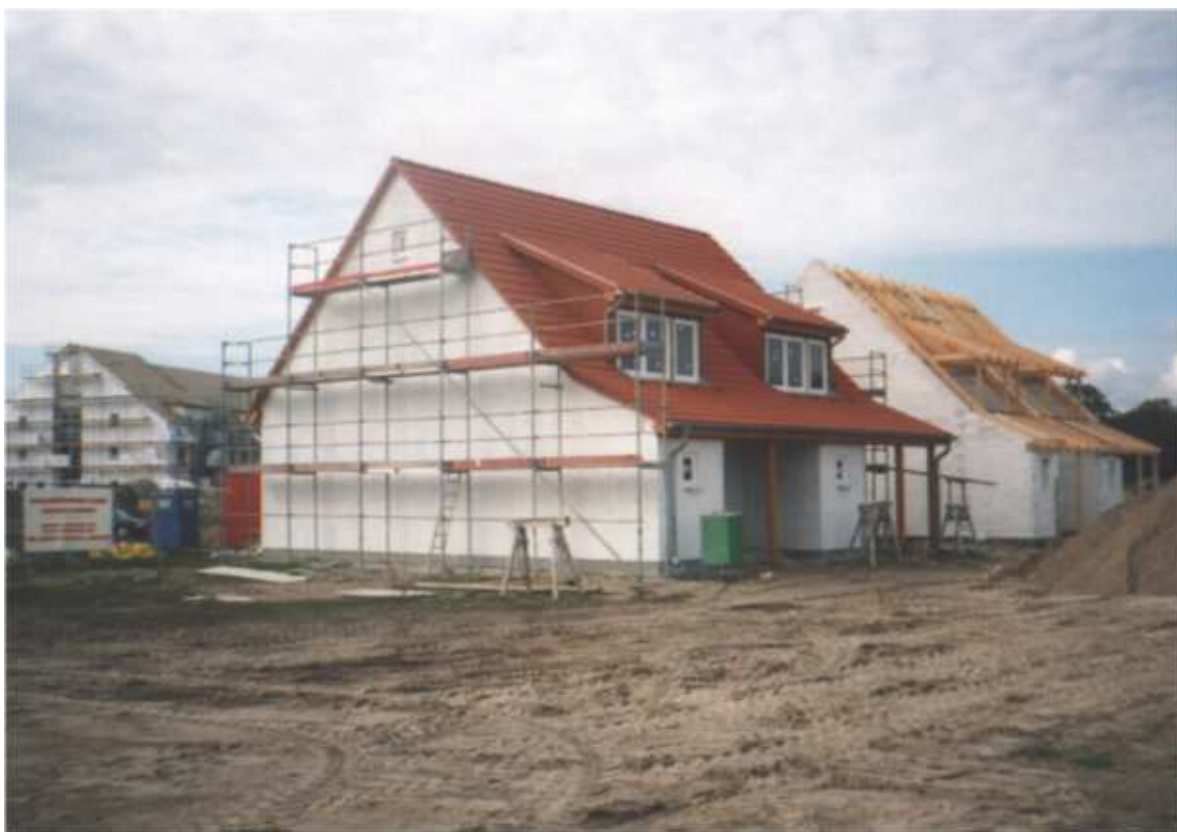
Bild 17: Bau von neuen Eigenheimen in der Messingwerkstrasse
