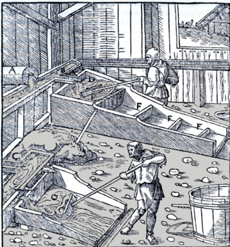
Piani inclinati dove scorre l'acqua per eliminare il materiale non mineralizzato
