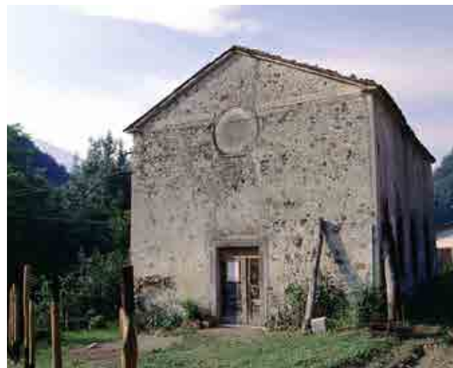
All'imbocco della Val dei Mercanti, nell'area del Reuchemberg e dei forni fusori, l'antica chiesetta di San Marco ora in ristrutturazione
